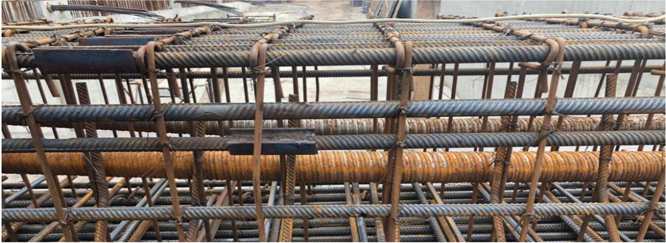
Рис. 2 - Фактическое выполнение преднапряжения перекрытия паркинга
