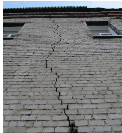
Рисунок 2 - Характерные трещины на стенах зданий от деформации грунтового основания
