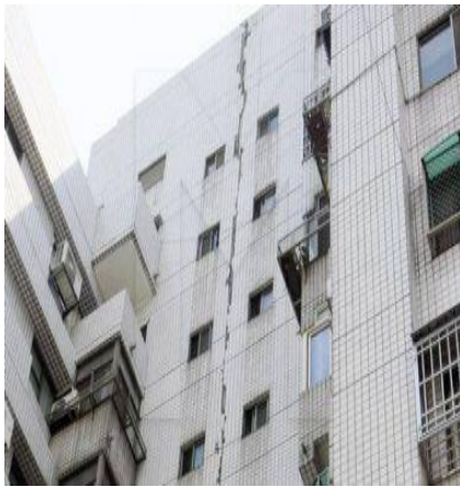
Рисунок 2 - Характерные трещины на стенах зданий от деформации грунтового основания
