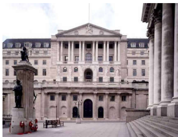
Фрагмент входной группы
