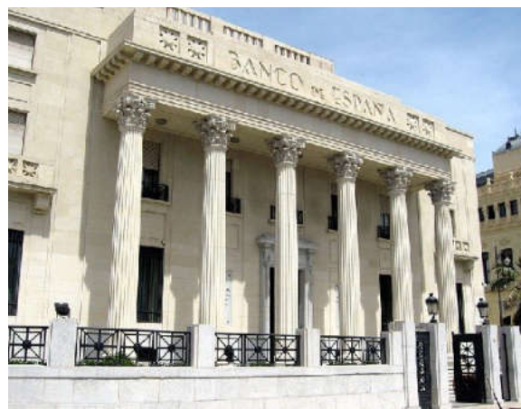
Фрагмент входной группы
