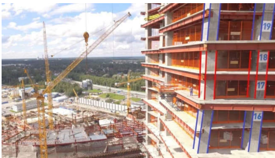
Сурет 4. Мұнараның бұралатын пішінін жасау үшін арналған «Лахта центр» еңісі бар бағаналары
