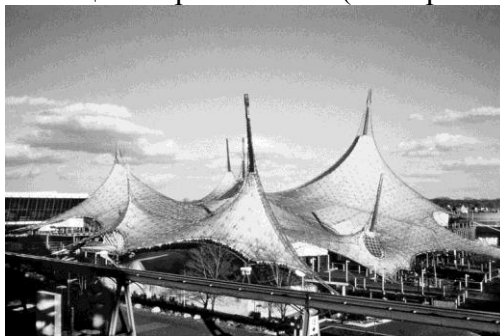
Рис.2 Для павильона на ЭКСПО 67 Отто разработал сверхлегкие натяжные системы
