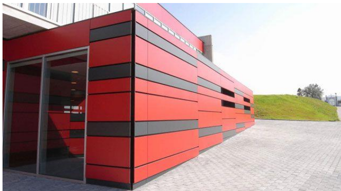
Рисунок 2.1 Фасад из композитных материалов
