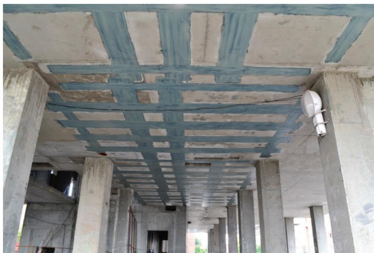
Сурет 2. Көміртекті талшықтармен еден плиталарын күшейту
