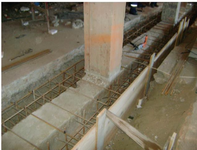
Сурет 1. Таспалы іргетасты темірбетон құрсамасымен нығайту
