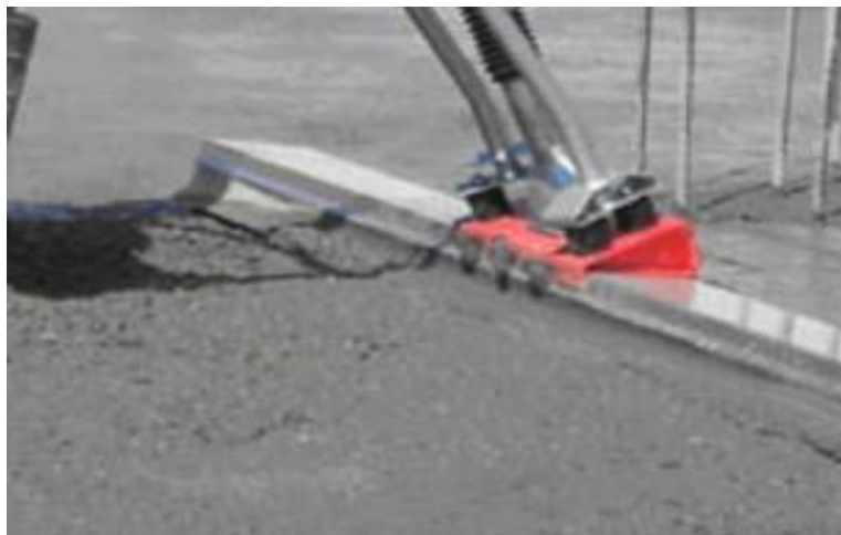
Сурет.3 .Бетон қоспасын құрылғымен тығыздау
