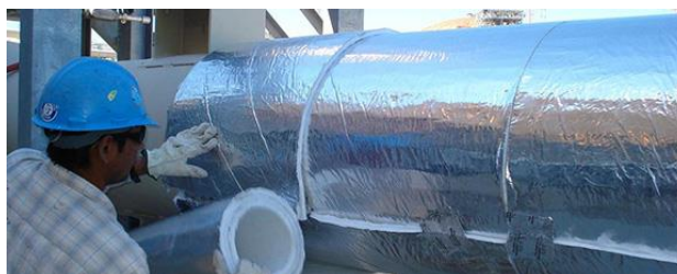
Рисунок 2. Утепление трубопровода с помощью аэрогеля
