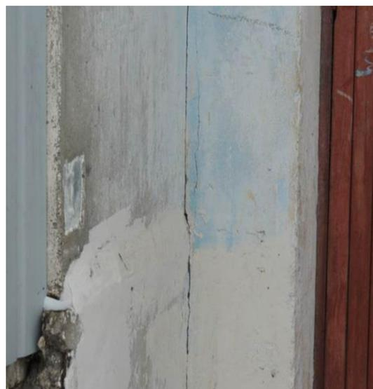
Рис.2,3. Оголение арматуры, нарушение связности и прочности сцепления цементного камня
