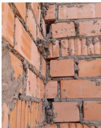
Рисунок 7. Неполное заполнение растворных швов, т.н. "пустошовка"
