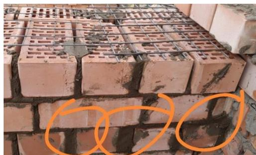
Рисунок 6. Утолщение растворных швов свыше допуска
