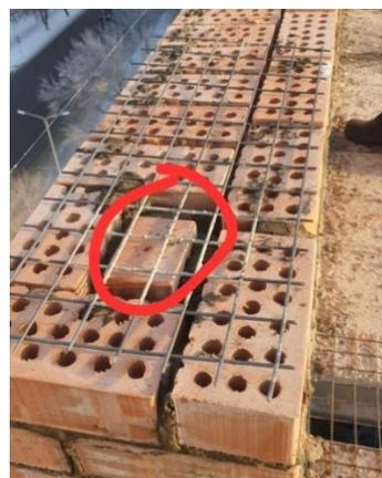
Рисунок 8. Кирпич уложен ребром
