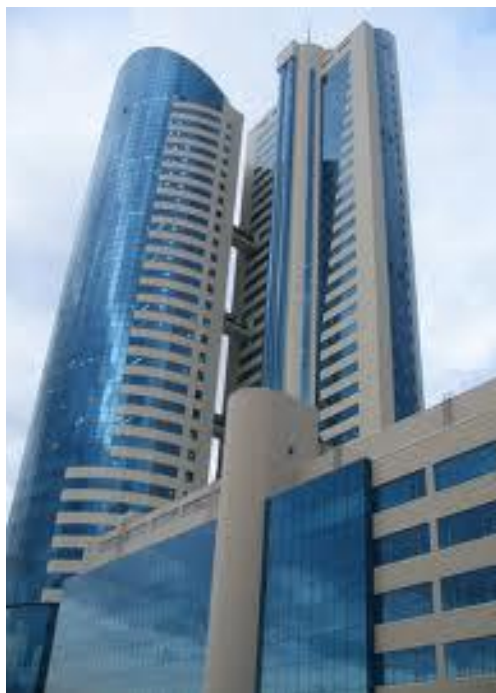
Рис. 2. Общий вид «Административного здания КТЖ»
