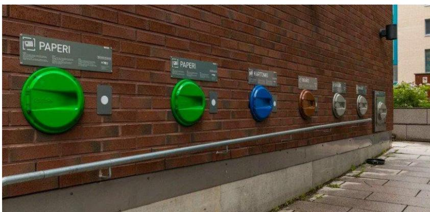
Рисунок 2 – Вакуумные мусоропроводы для сортированного мусора в Хельсинки, Финляндия
